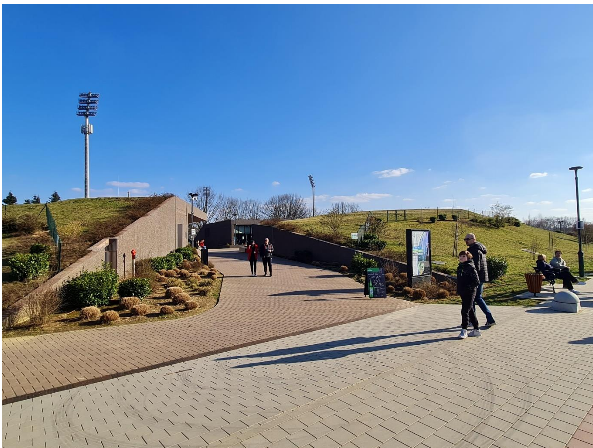
Slika 9 Slatkovodni akvarij, zgrada sa zelenim krovom na šetnici uz Koranu
